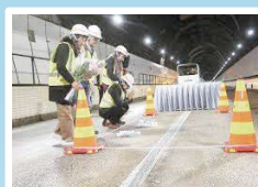
トンネル内作業
