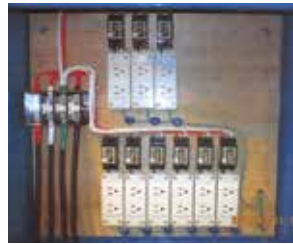
9回路分電盤内部
