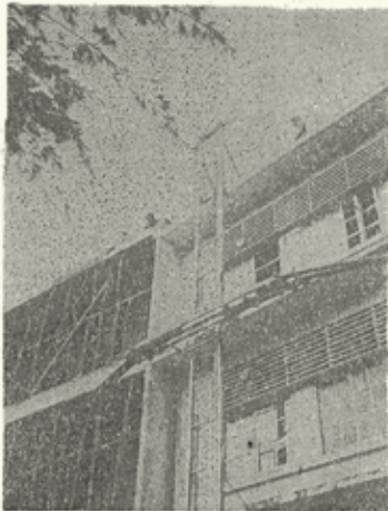
積工建設の工場現場で威力を発揮する新型リフト
