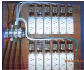
12回路分電盤内部
