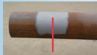
金属パイプ錆落とし
